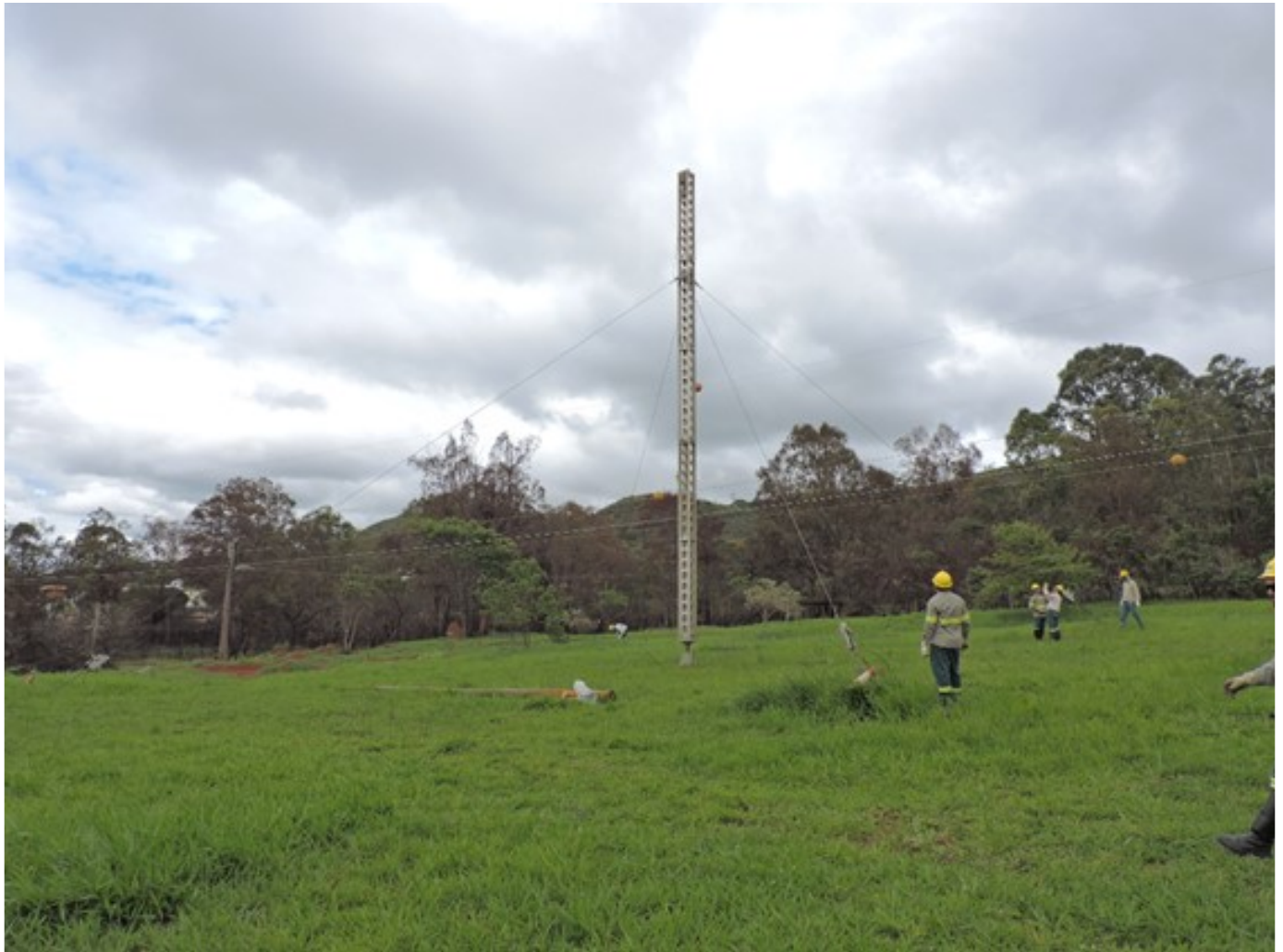
Figura 11 – Torre de emergência montada
